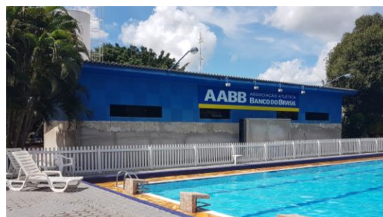
Obras da fachada do vestiário.
