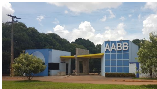
Obras da fachada na entrada.
