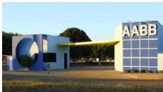
Fachada na entrada atualmente.
