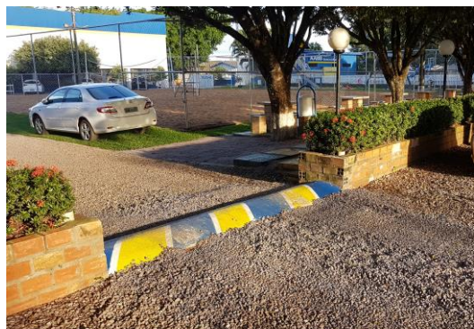
Lombada no estacionamento.
